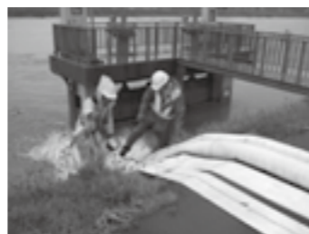
梯川左岸2.2k付近 九竜橋川排水機場の排水ポンプ車作業状況▶P. 3
