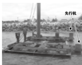
先行杭 導枠の構造および使用方法▶P. 7
